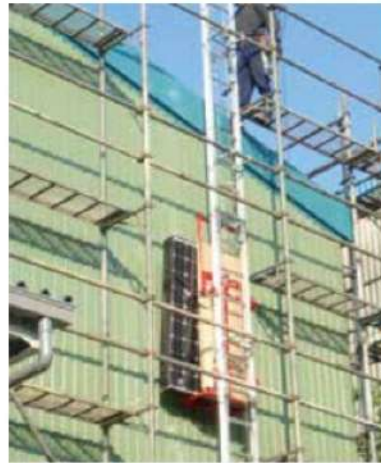
足場の内側に設置し、屋根上まで荷揚げ可能。ウインチ操作は屋根上でも可能
