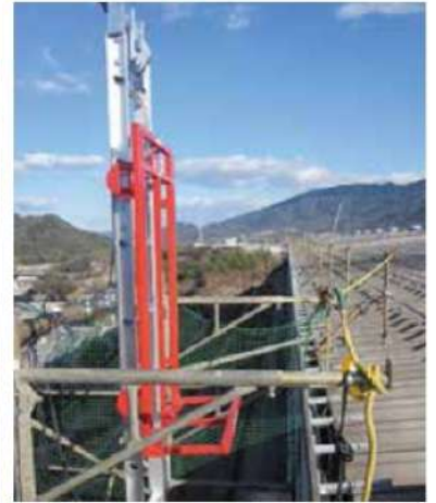
足場の内側に設置し、屋根上まで荷揚げ可能。ウインチ操作は屋根上でも可能
