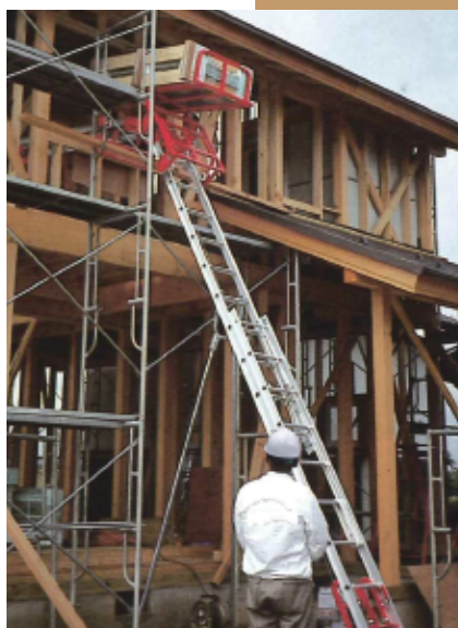
専用二重台車で窓から室内へスムーズに引き込みます。
