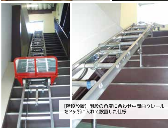
【階段設置】階段の角度に合わせて中間曲りレールを1ヶ所に入れて設置した仕様
