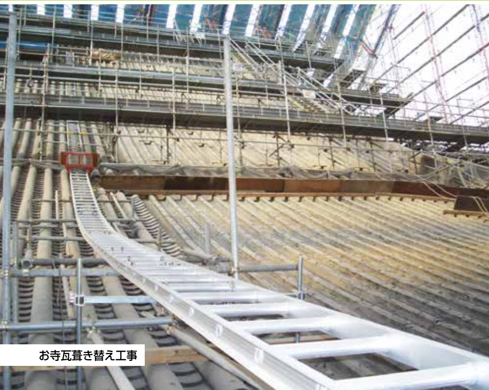
階段設置工事
