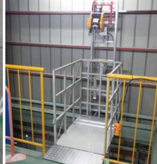
【垂直設置】（箱型台車スロープ付）スロープ付で手押し台車のまま積込、積降ろしができる仕様
