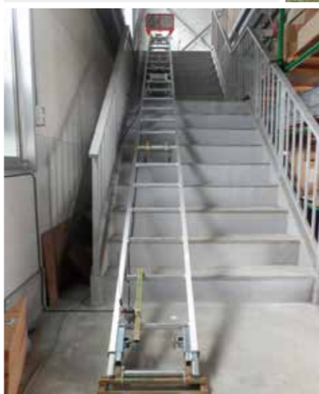
【階段設置】階段の角度に合わせて中間曲りレールを1ヶ所に入れて設置した仕様
